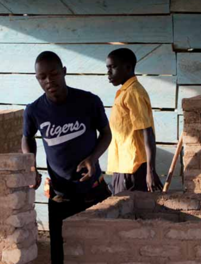
Maurerlehrlinge lernen beim Bau verschiedener Mauern. (Foto: KVDP)
