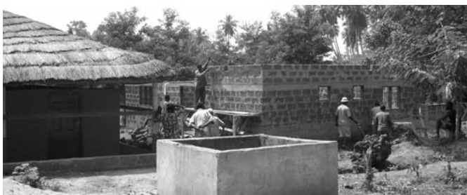
Schwesterwohnhaus in Rohbauphase
